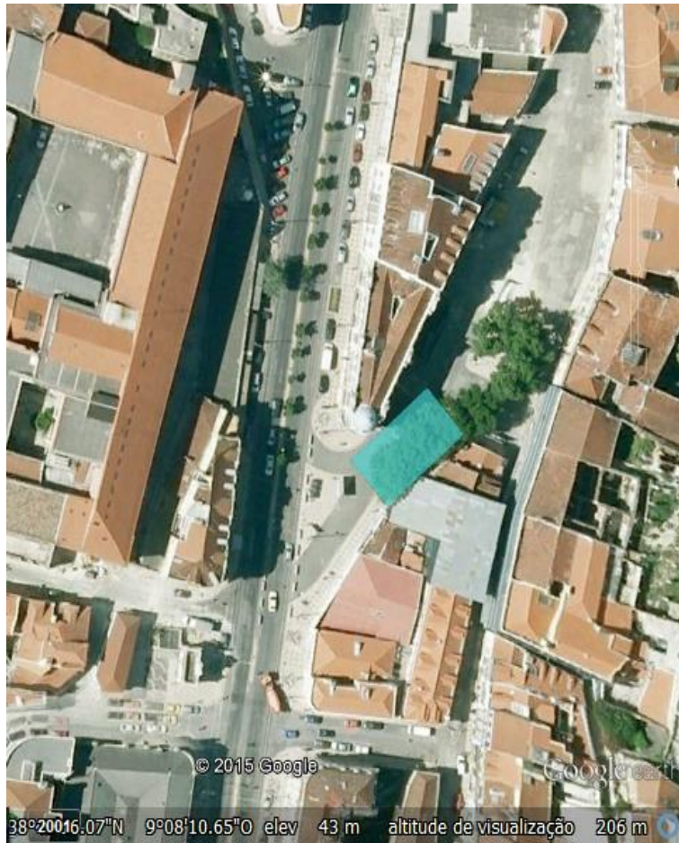
Figura 5.18 - Zona ocupada pelo reservatório no Largo do Intendente (Google, 2015).
