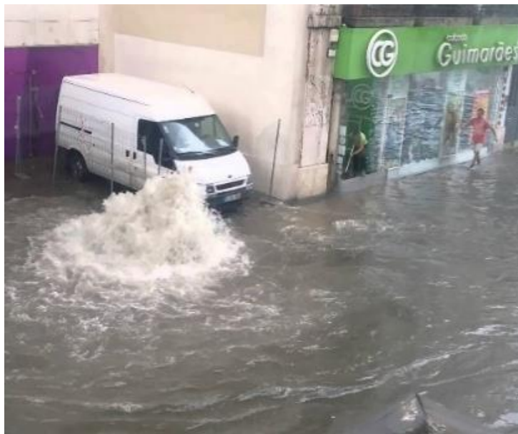
Figura 4.9 - Tapa de caixa de visita que saltou devido ao coletores estarem em carga.
